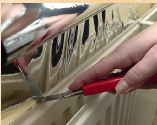
Foto: radiatorfolie aangebracht
