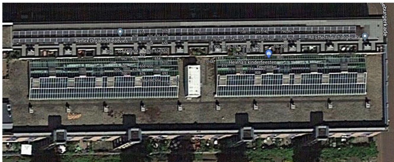
Bovenaanzicht dak van zuid naar noord: let op schaduwvlakken
