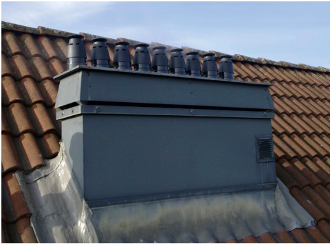
Dakdoorvoeren van individuele RGA
